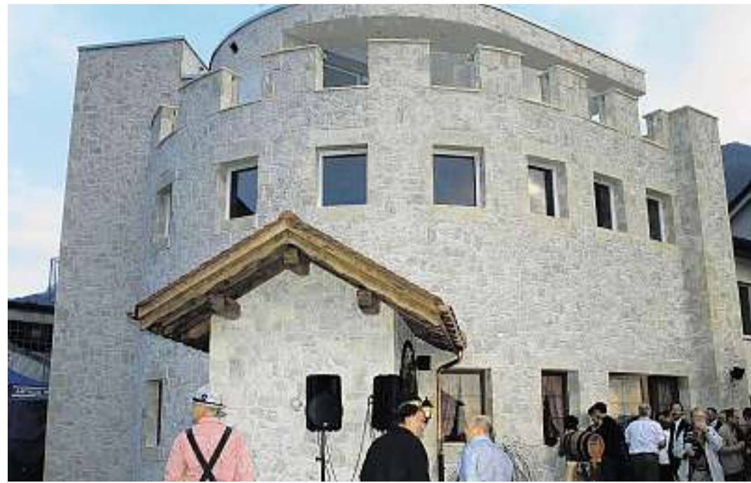
Eine eindrückliche Burg in Oberarth: Der gelungene An- und Umbau beim Restaurant Schöntal in Oberarth Bild Alfred Wolf
